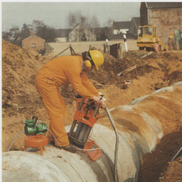
GÖLZ-KB 300 mit Saugplattenbefestigung
