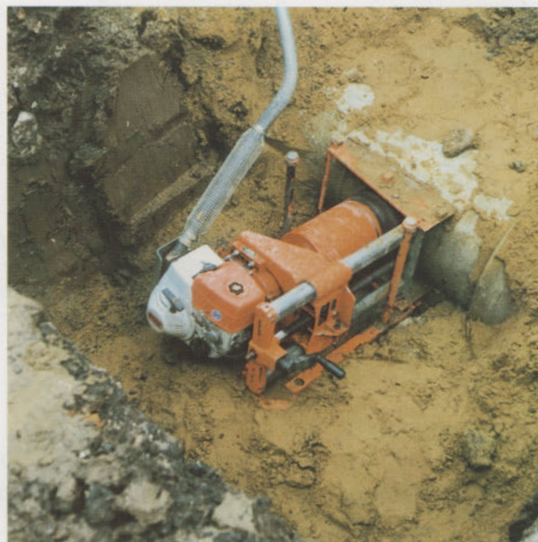
Bohrung im Graben mit Erdnägeln
